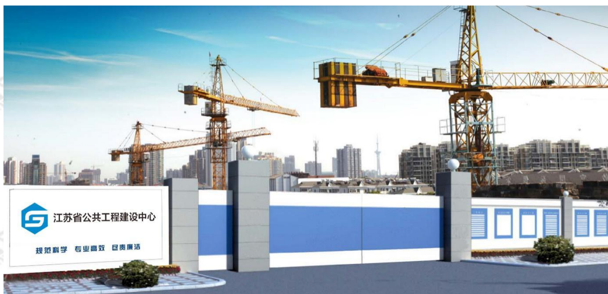
图 24 施工现场大门（无梁式）
