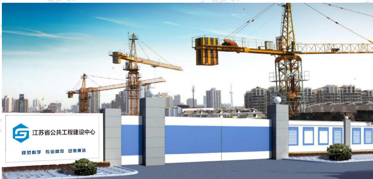
图 24 施工现场大门（无梁式）
