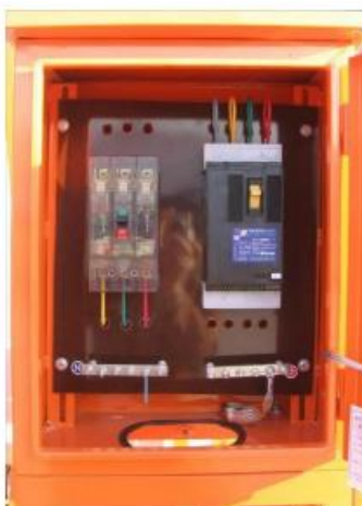
图 8-5 开关箱标准配置参照图图 8-6 电焊专用箱标准配置参照图
