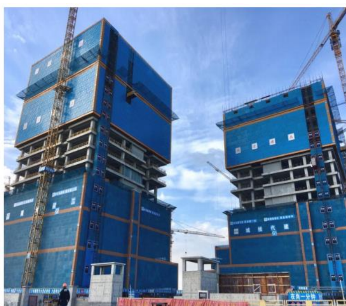
图 7-18 外脚手架安全网片参照图
