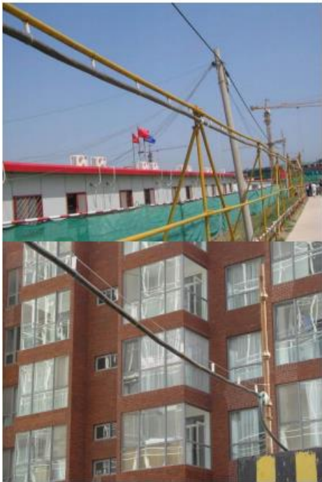
图 8-7 电缆架空敷设标准参照图
