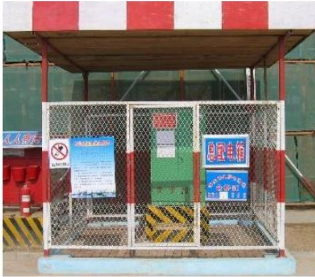
图 8-3 配电箱标准防护参照图
