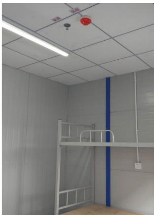
图 3-19 宿舍布置参照图（喷淋、烟感等）
