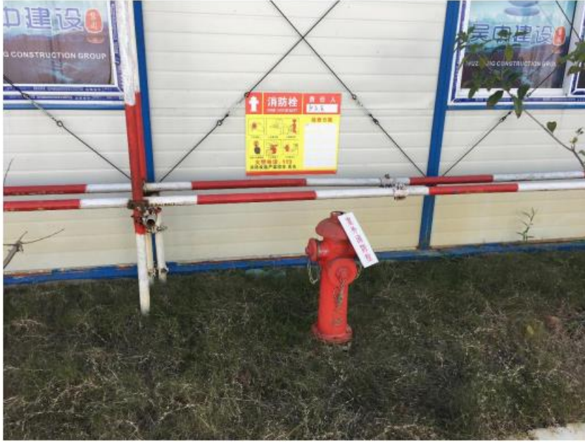
图 4-6 室外消火栓系统参照图
