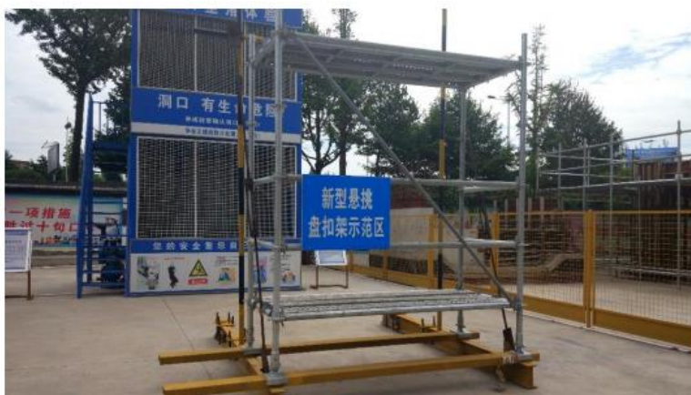
图 7-17 悬挑盘扣脚手架参照图
