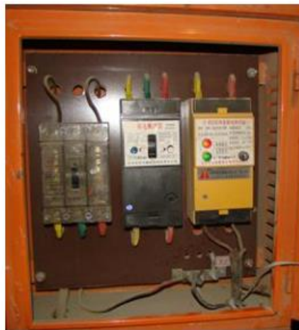
图 8-5 开关箱标准配置参照图图 8-6 电焊专用箱标准配置参照图
