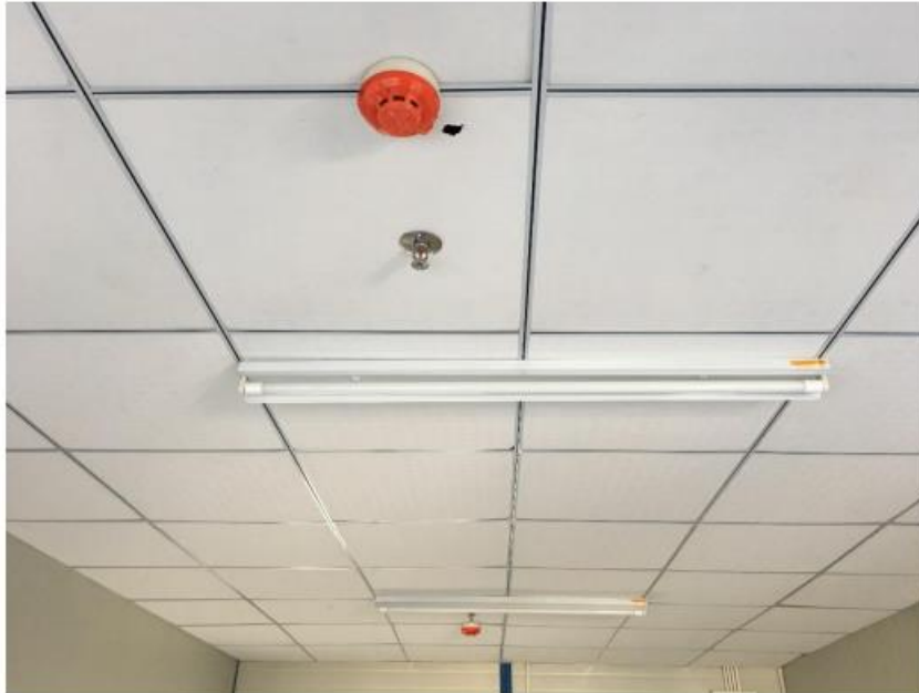
图 4-5 室内设喷淋、烟感参照图
