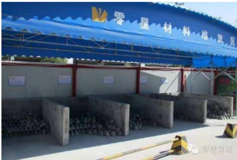
图 11-2 零星材料堆放参照图
