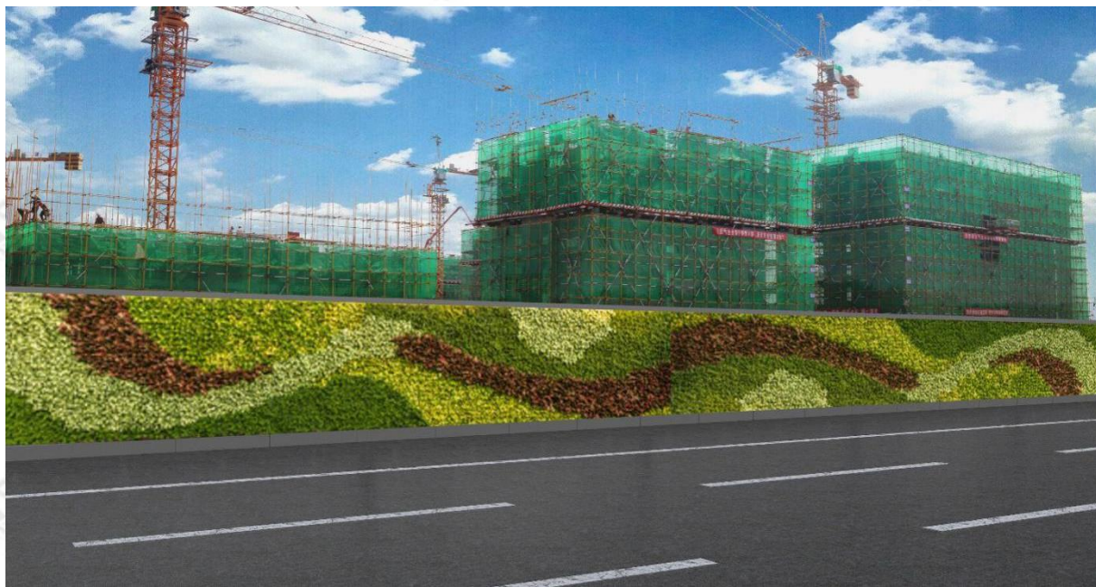
图 13 人工草皮砌筑式围挡
