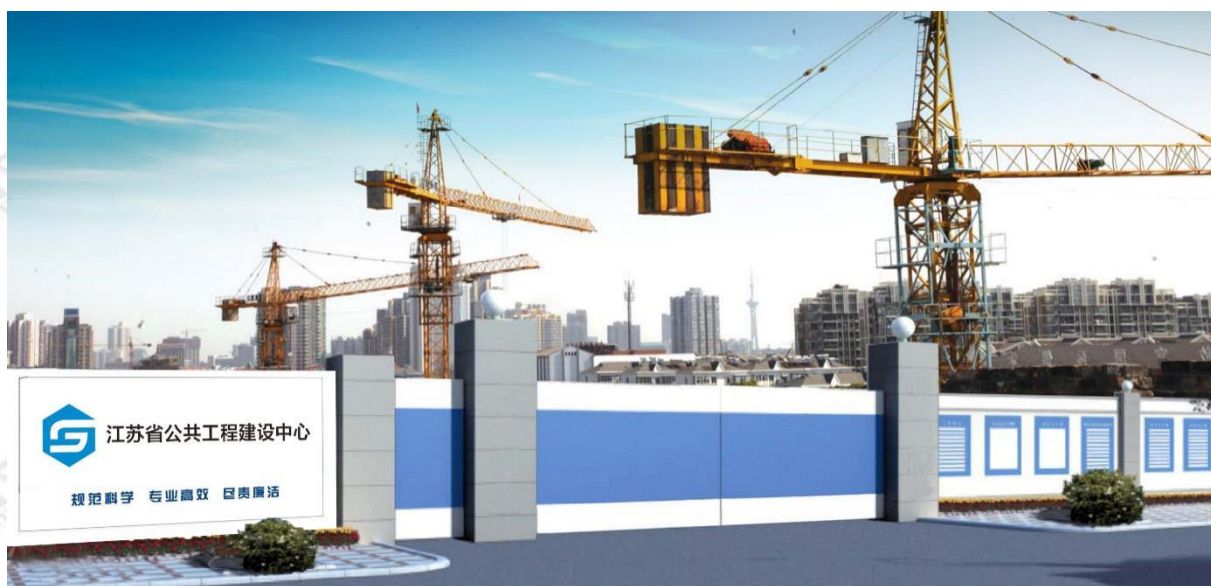
图 24 施工现场大门（无梁式）
