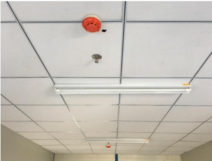
图 4-5 室内设喷淋、烟感参照图
