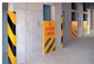
电梯井门洞全封闭式防护门
