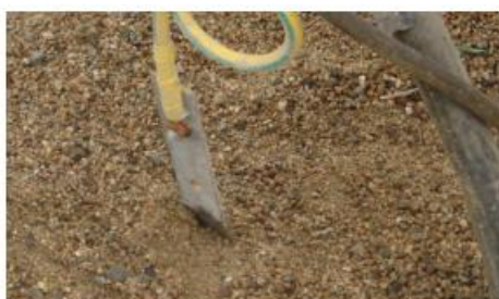
图 8-9 接地体与配电箱的标准连接参照图（接地体扁铁通过黄绿双色线与 PE 排连接）
