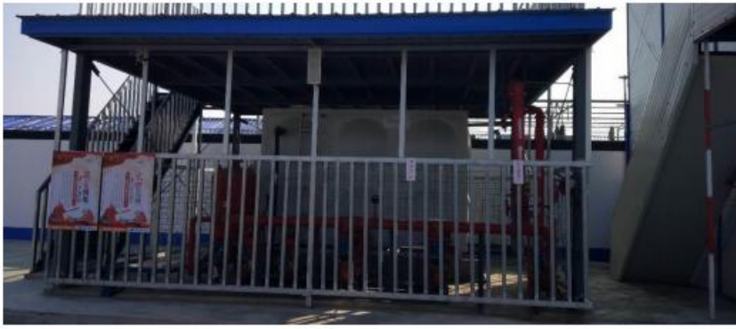
图 4-3 消防水箱和消防泵组参照图
