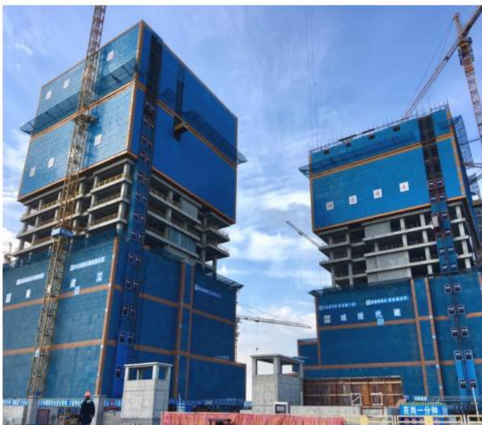
图 7-18 外脚手架安全网片参照图
