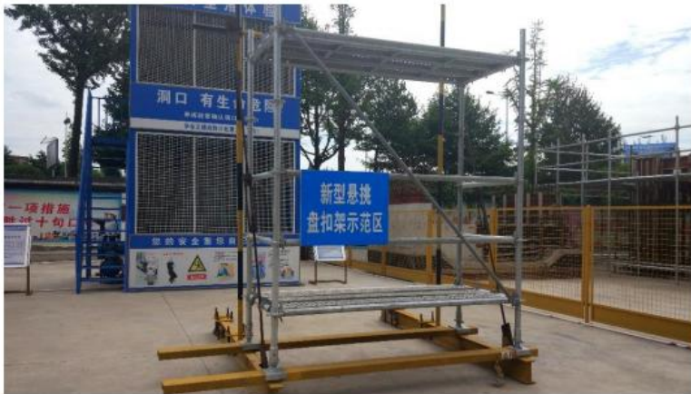
图 7-17 悬挑盘扣脚手架参照图
