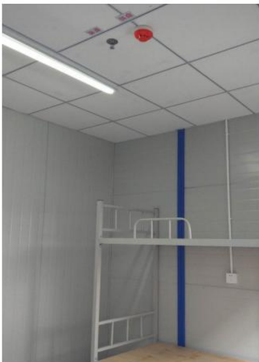
图 3-19 宿舍布置参照图（喷淋、烟感等）
