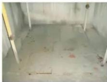
电梯井洞口模板水平防护实物图
