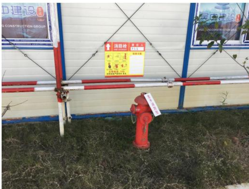
图 4-6 室外消火栓系统参照图
