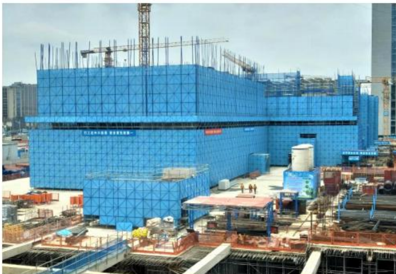
图 7-19 外脚手架安全网片参照图
