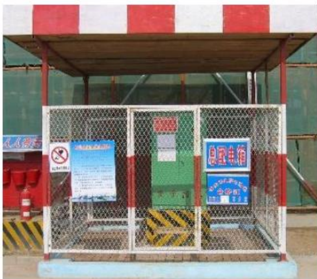
图 8-3 配电箱标准防护参照图
