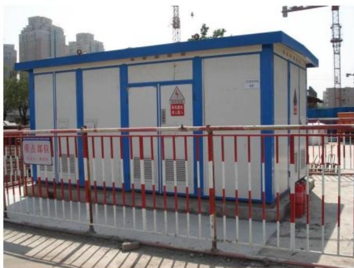
图 8-1 箱变标准防护参照图
