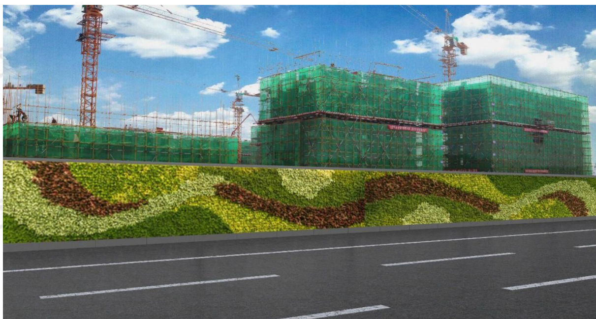
图 13 人工草皮砌筑式围挡
