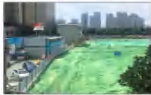
6针防尘网裸土覆盖
