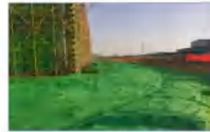
6针防尘网裸土覆盖
