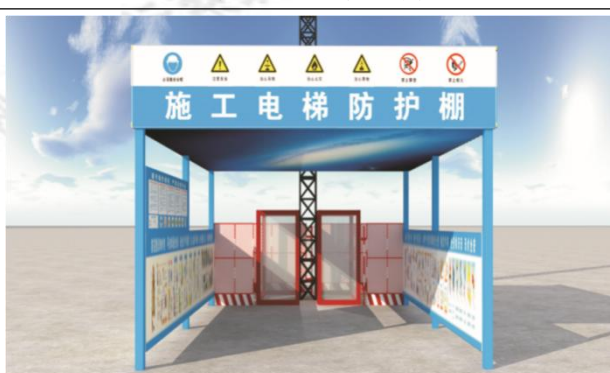
图 37 施工电梯防护棚
