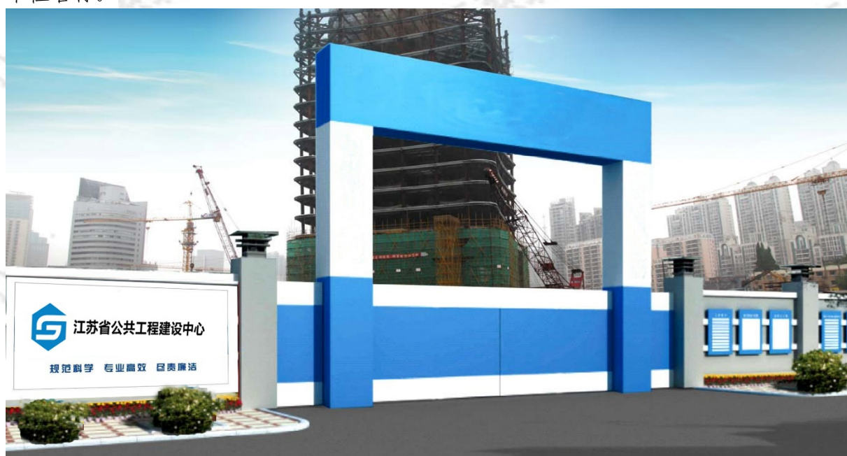
图 23 施工现场大门示意
