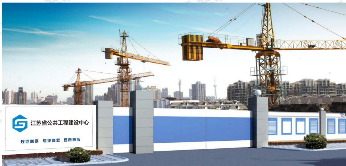
图 24 施工现场大门（无梁式）
