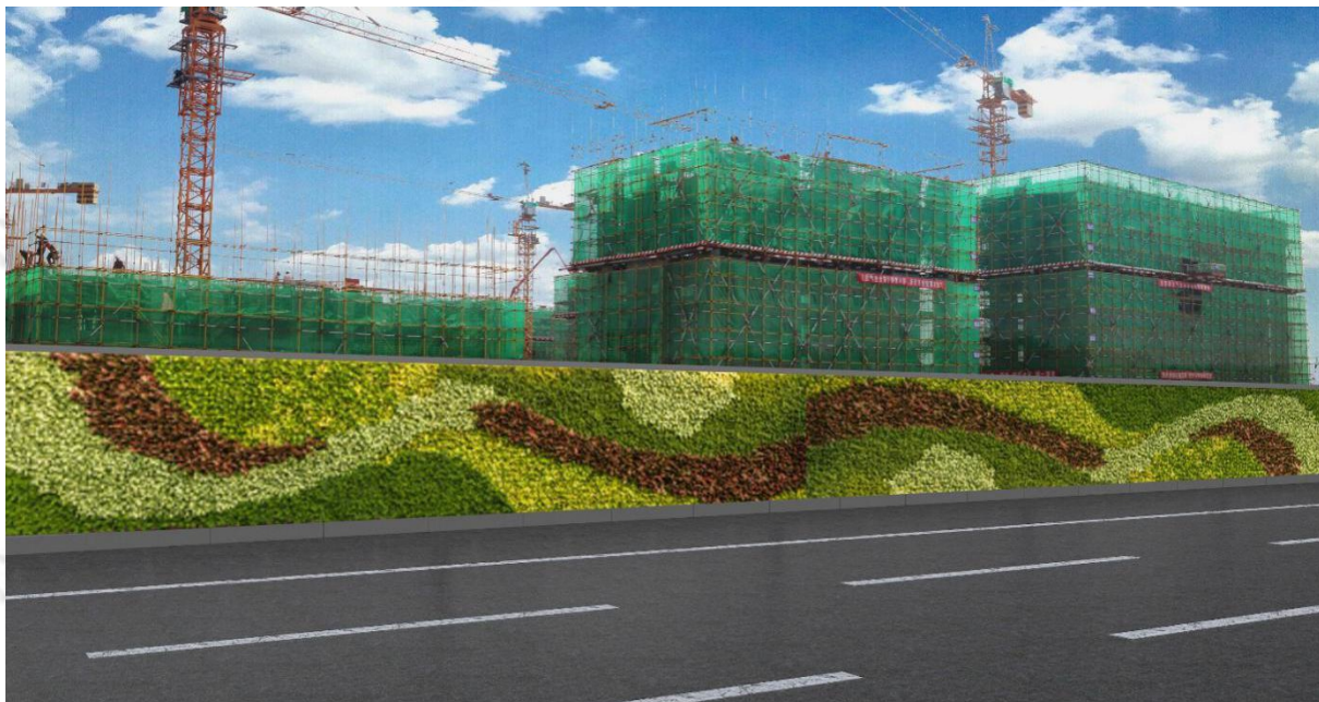
图 13 人工草皮砌筑式围挡
