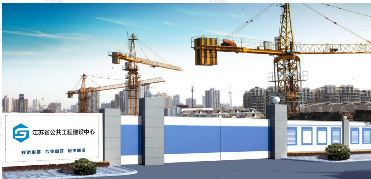
图 24 施工现场大门（无梁式）
