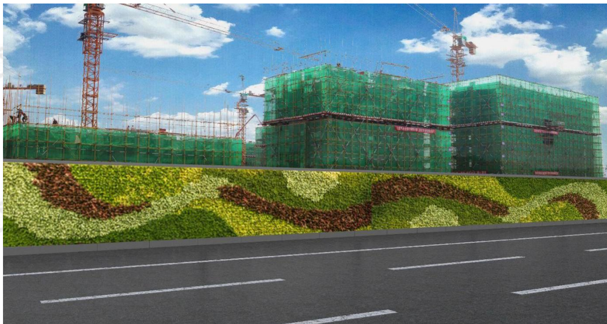
图 13 人工草皮砌筑式围挡
