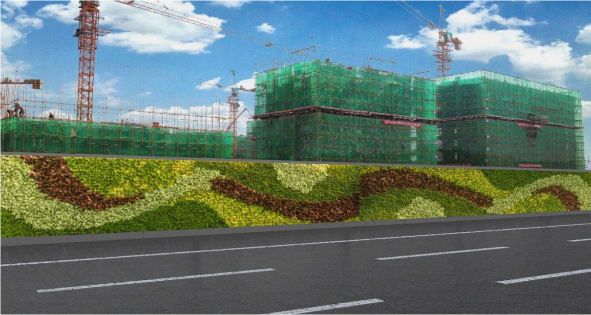
图 13 人工草皮砌筑式围挡
