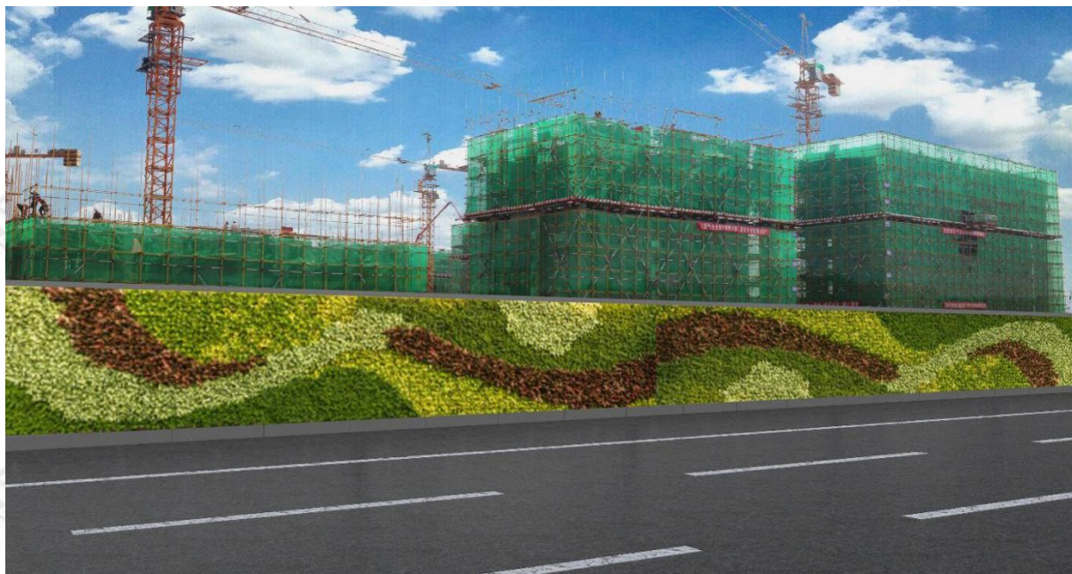
图 13 人工草皮砌筑式围挡
