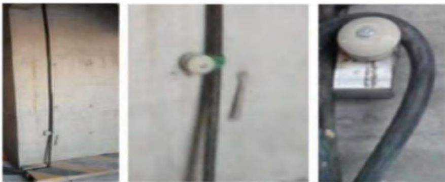
竖向电缆敷设及固定
