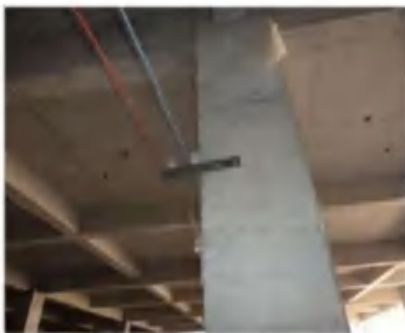
横向电缆敷设及固定
