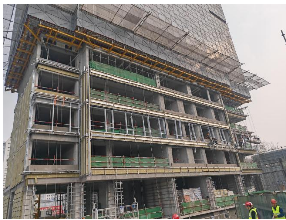
吊篮安装示意
