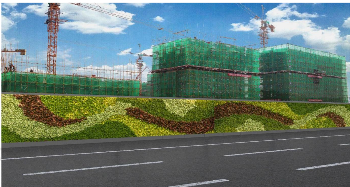
图 13 人工草皮砌筑式围挡
