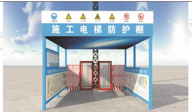
图 37 施工电梯防护棚
