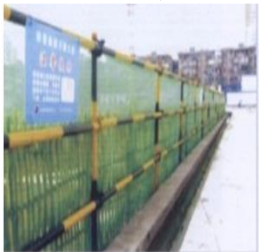
17、基坑围护护栏（高度 \geq 1.2\text{m} ）
