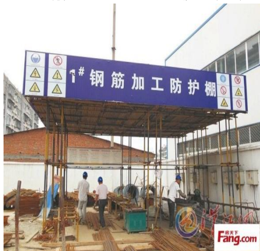
35、钢筋加工棚（木工、搅拌机等加工棚参照此类型） 36、钢筋堆放
