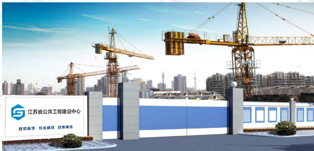
图 24 施工现场大门（无梁式）
