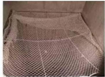
图 7-4 电梯井洞口防护正立面图
