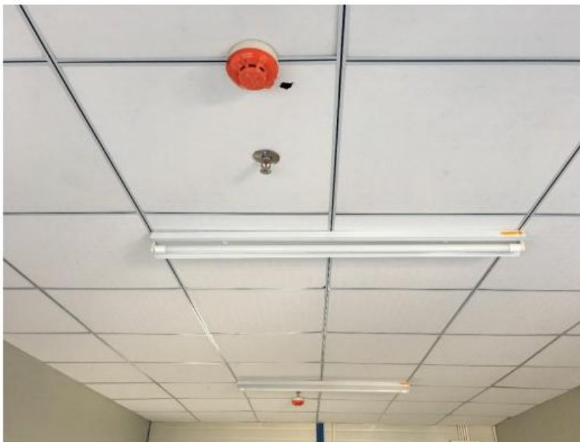
图 4-5 室内设喷淋、烟感参照图
