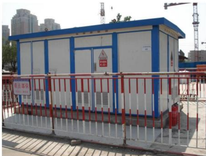
图 8-1 箱变标准防护参照图
