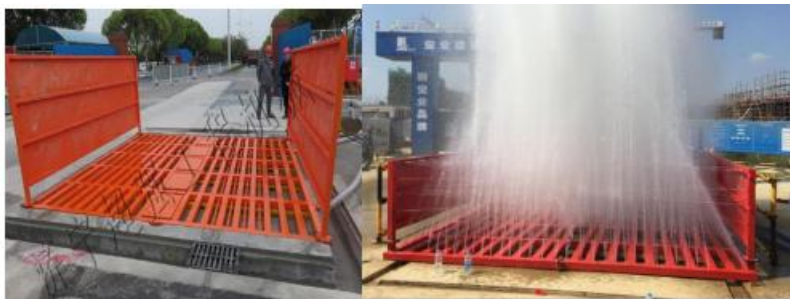
图 5-1 设置冲洗台参照图
