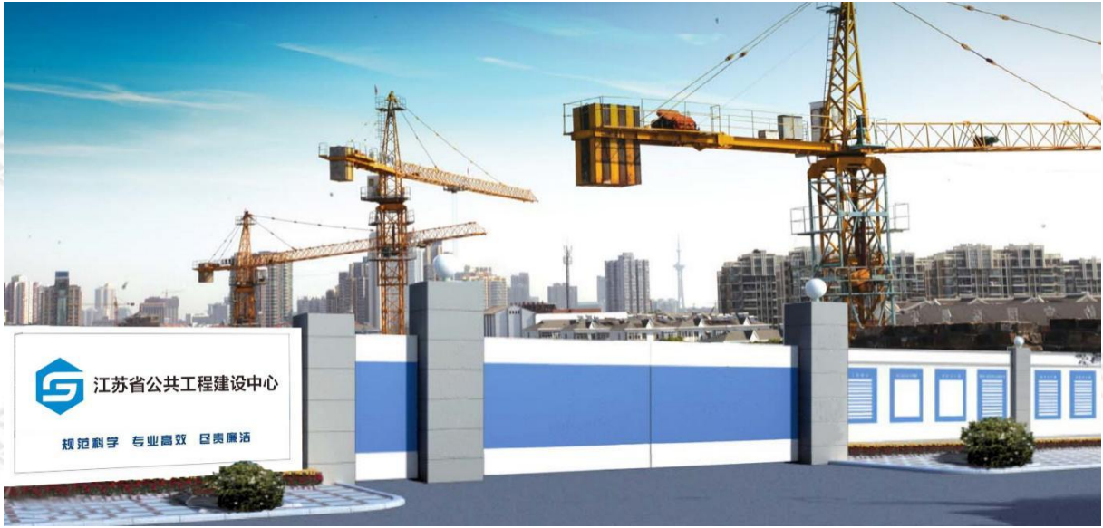
图 24 施工现场大门（无梁式）
