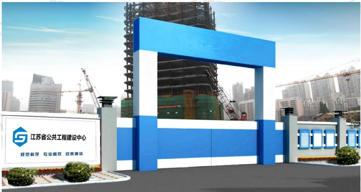
图 23 施工现场大门示意
