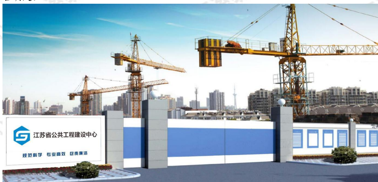
图 24 施工现场大门（无梁式）
