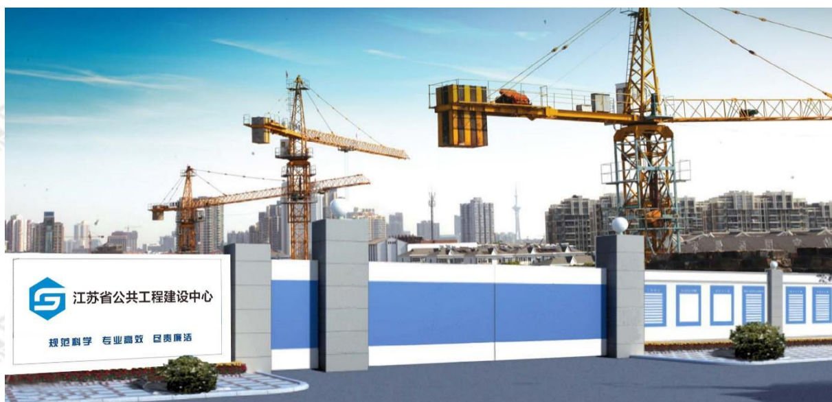
图 24 施工现场大门（无梁式）
