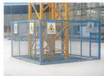
● 塔吊基础围护实景图
