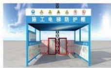
施工电梯防护棚
