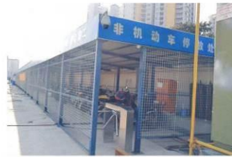
● 电瓶车防护棚实景图
