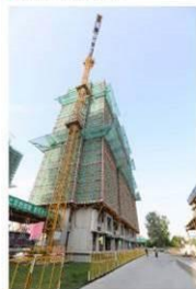
● 塔吊附着平台围护实景图
