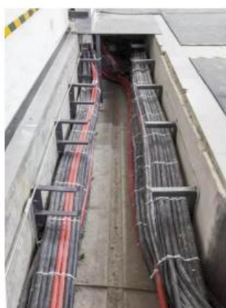
图 8-7 电缆架空敷设标准参照图
