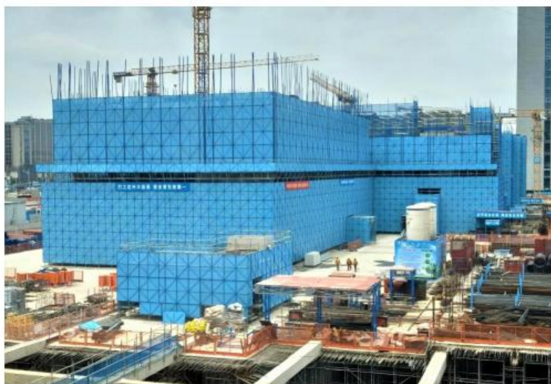
图 7-19 外脚手架安全网片参照图
