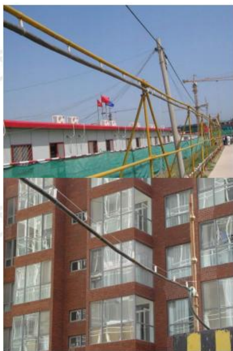
图 8-7 电缆架空敷设标准参照图
