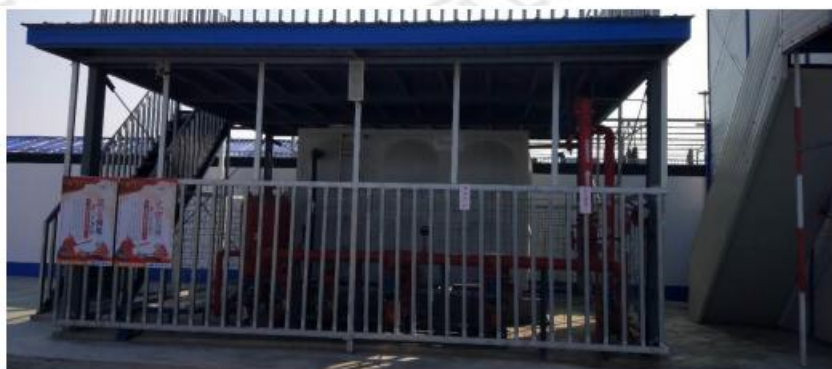
图 4-3 消防水箱和消防泵组参照图
