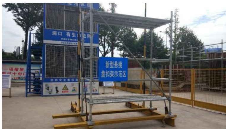
图 7-17 悬挑盘扣脚手架参照图
