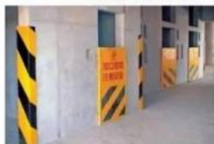
电梯井门洞全封闭式防护门
