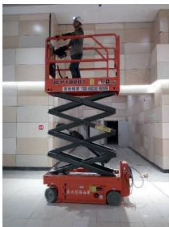
图 7-20 移动式操作平台图 7-21 移动式操作平台
