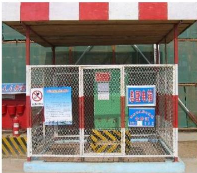
图 8-3 配电箱标准防护参照图
