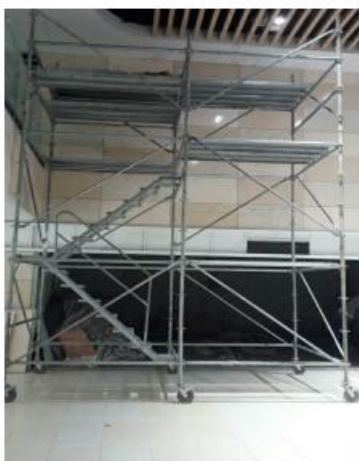
图 7-20 移动式操作平台图 7-21 移动式操作平台
