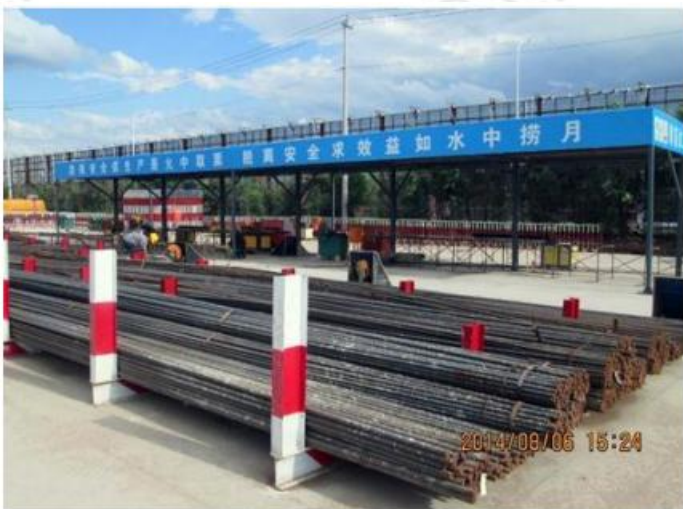
图 10-1 钢筋棚及钢筋堆放参照图
