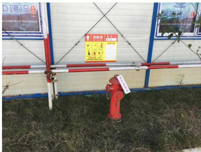
图 4-6 室外消火栓系统参照图
