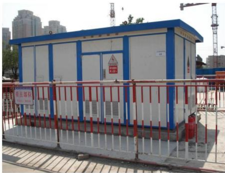
图 8-1 箱变标准防护参照图
