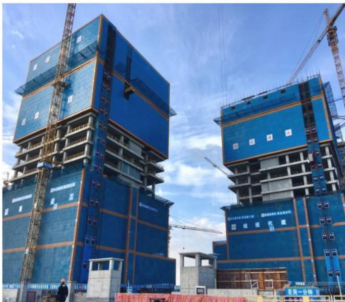
图 7-18 外脚手架安全网片参照图
