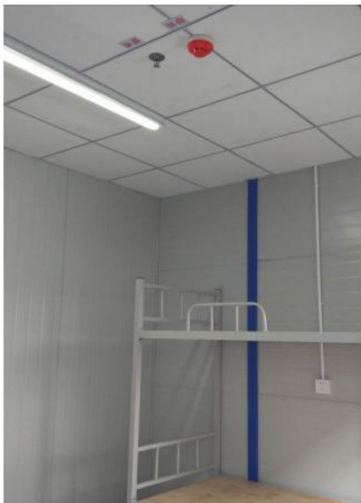
图 3-19 宿舍布置参照图（喷淋、烟感等）
