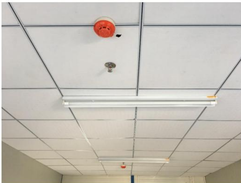
图 4-5 室内设喷淋、烟感参照图
