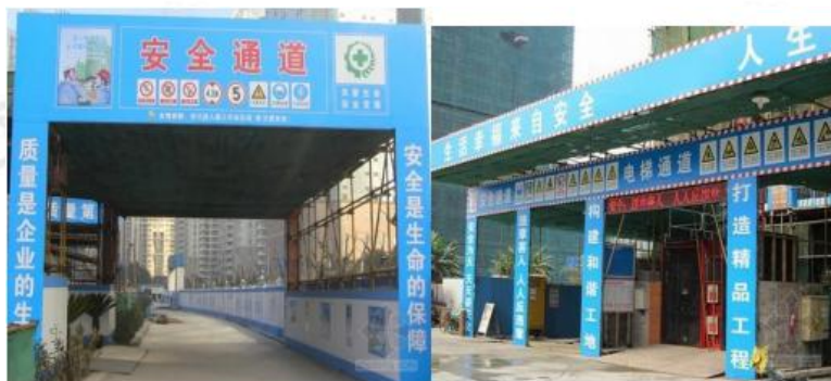
图 6-1 安全通道参照图
