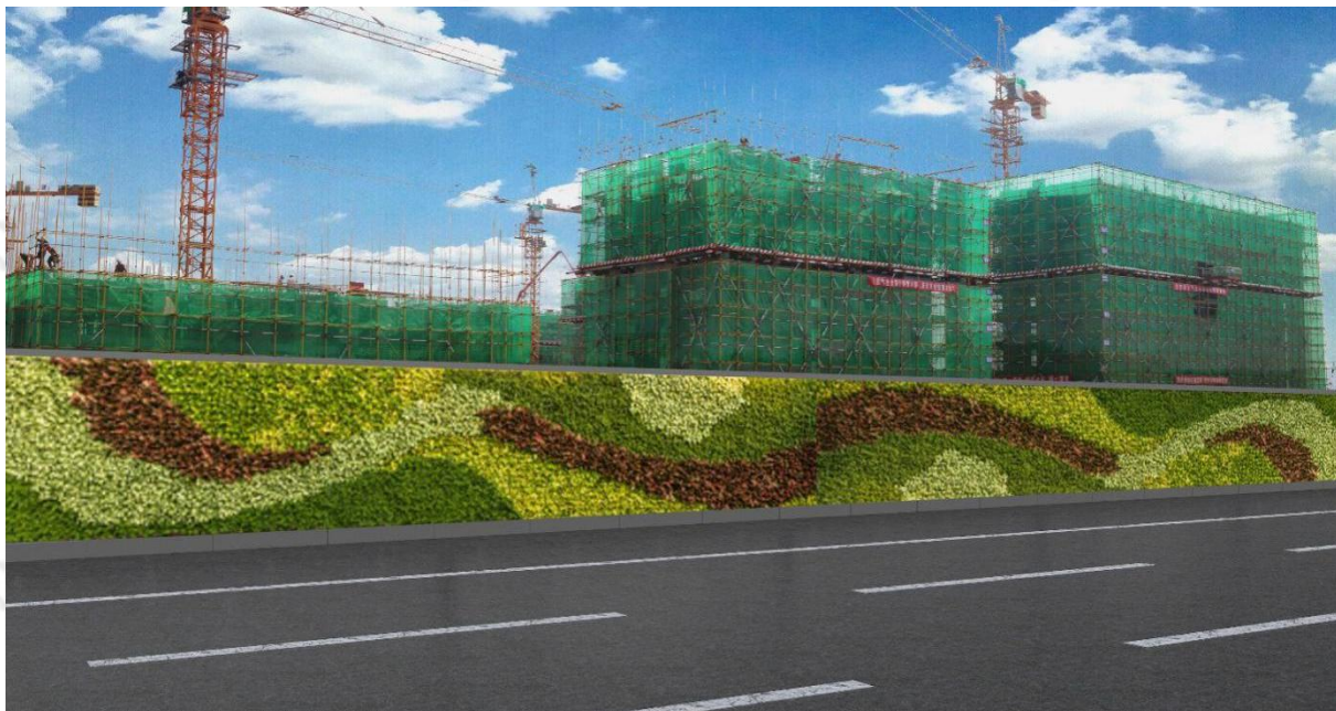
图 13 人工草皮砌筑式围挡
