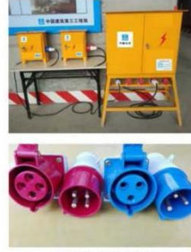
工业插座式配电箱及连接插头
