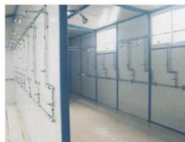
● 淋浴室实景图
