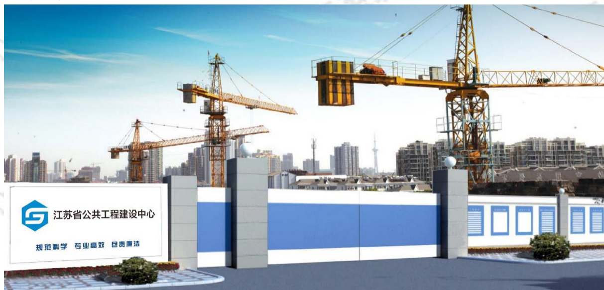
图 24 施工现场大门（无梁式）
