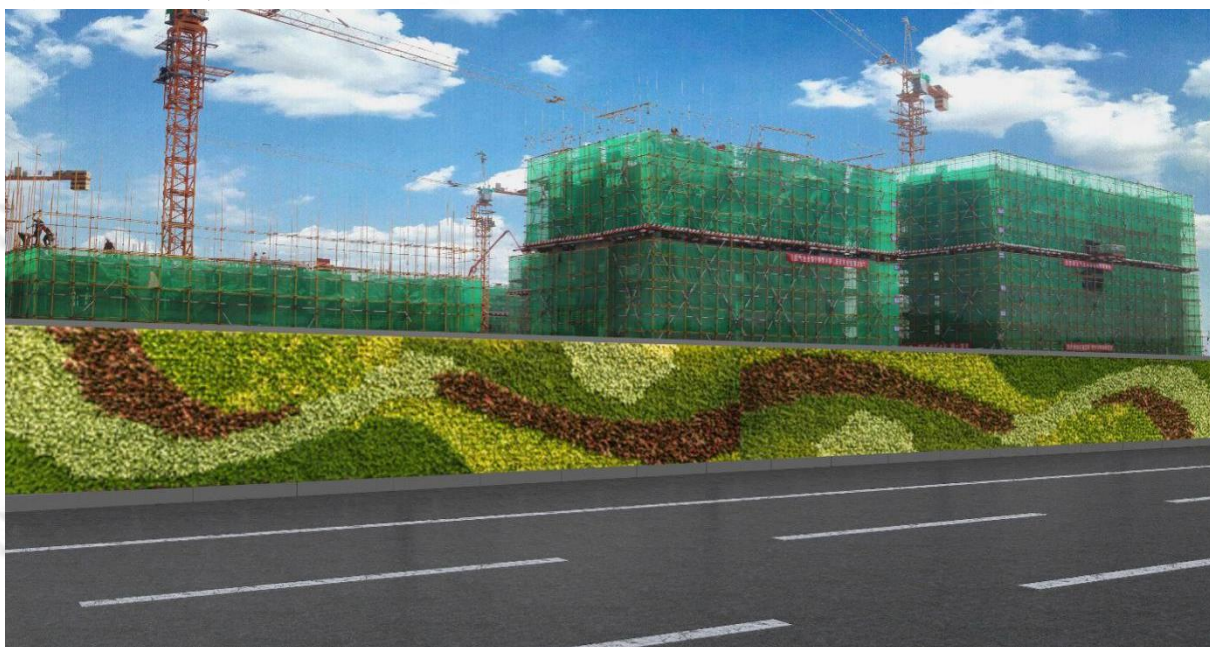
图 13 人工草皮砌筑式围挡
