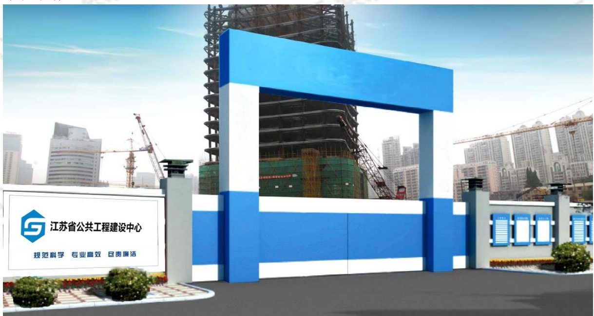
图 23 施工现场大门示意
