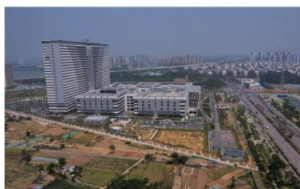
东南侧现状中医院新院
