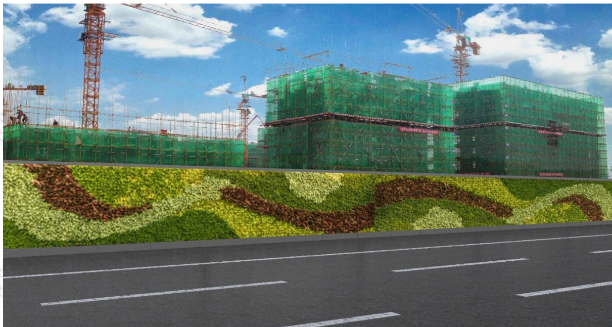
图 13 人工草皮砌筑式围挡
