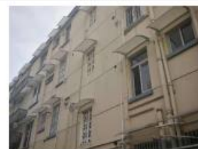
整修破损管线，拆除无用管线✓ 墙面管线与建筑立面不突兀✓ 重新整理管线，确保雨污分流✓
