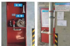
樓層消火栓設置
