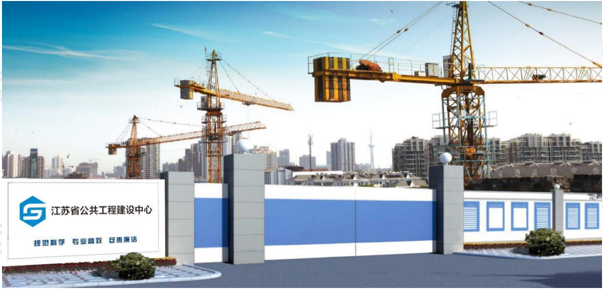
图 24 施工现场大门（无梁式）
