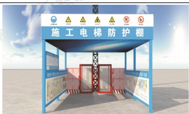
图 37 施工电梯防护棚
