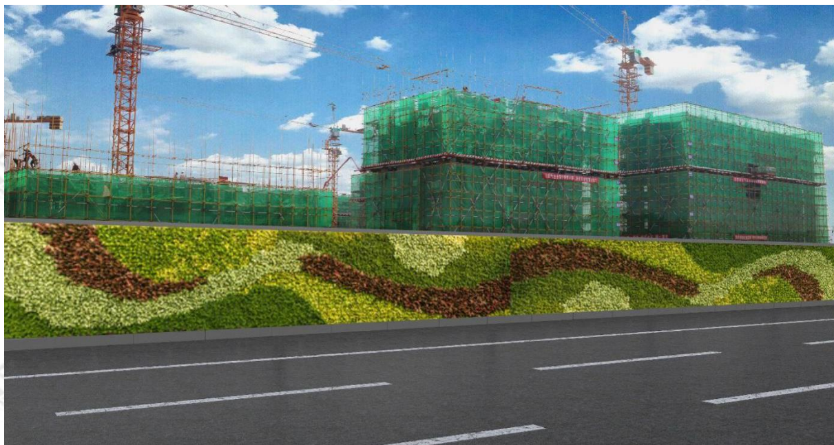
图 13 人工草皮砌筑式围挡
