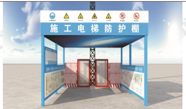
图 37 施工电梯防护棚
