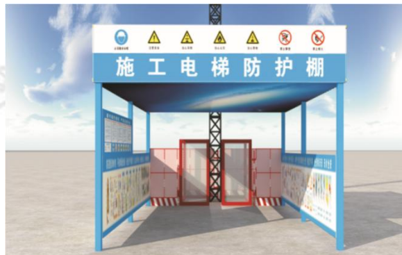
图 37 施工电梯防护棚
