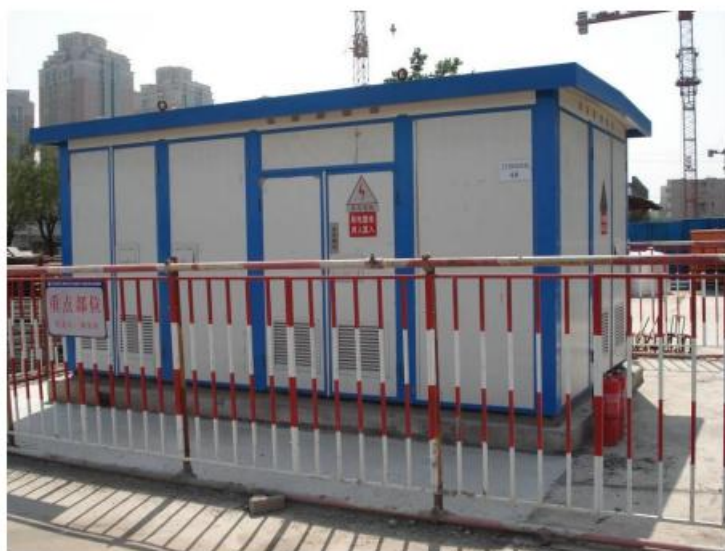
图 8-1 箱变标准防护参照图
