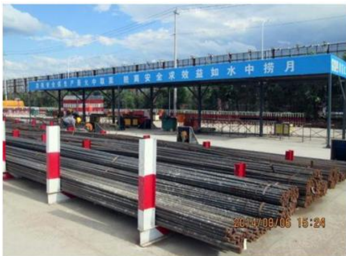
图 10-1 钢筋棚及钢筋堆放参照图
