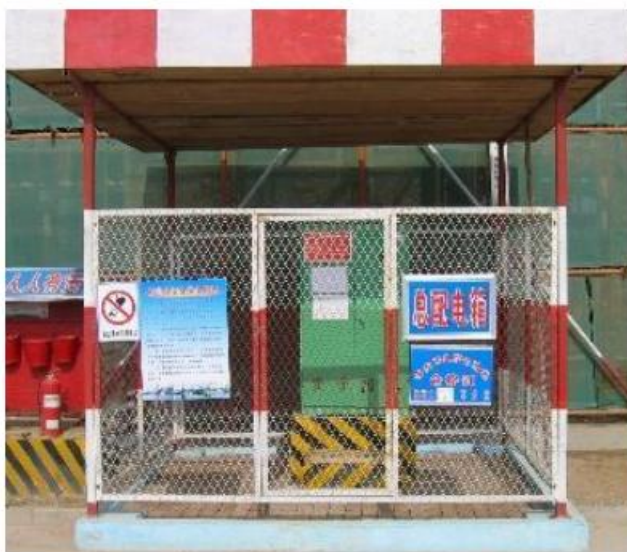
图 8-3 配电箱标准防护参照图
