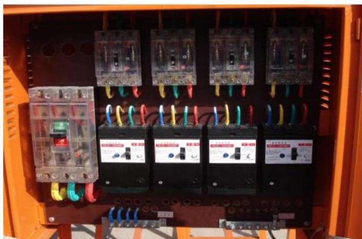
图 8-4 二级箱标准配置参照图
