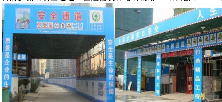
图 6-1 安全通道参照图
