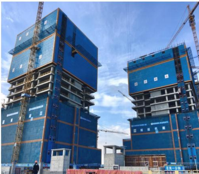
图 7-18 外脚手架安全网片参照图
