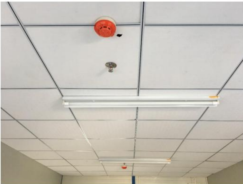
图 4-5 室内设喷淋、烟感参照图
