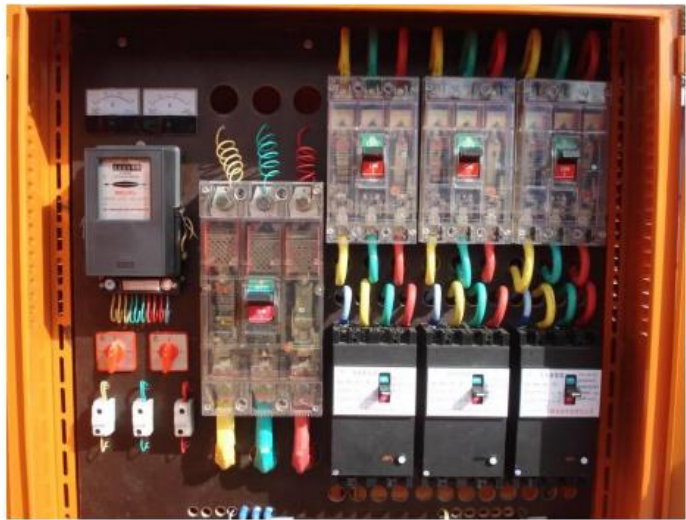
图 8-2 一级箱标准配置参照图
