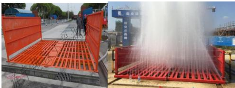
图 5-1 设置冲洗台参照图
