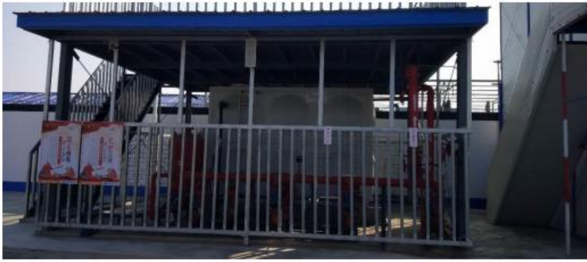
图 4-3 消防水箱和消防泵组参照图
