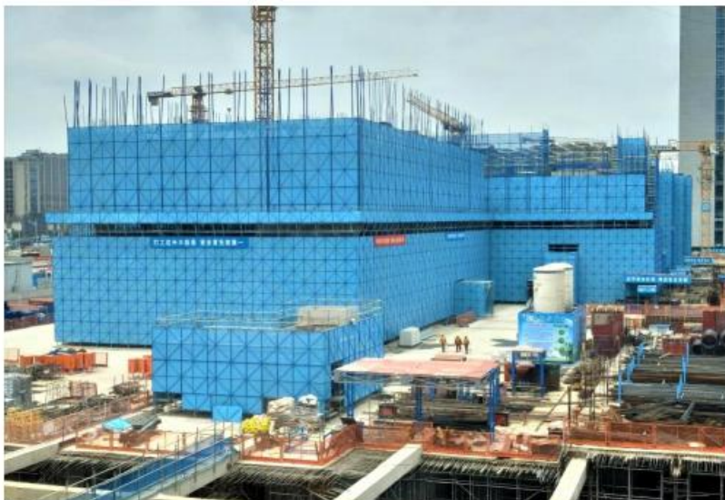
图 7-19 外脚手架安全网片参照图
