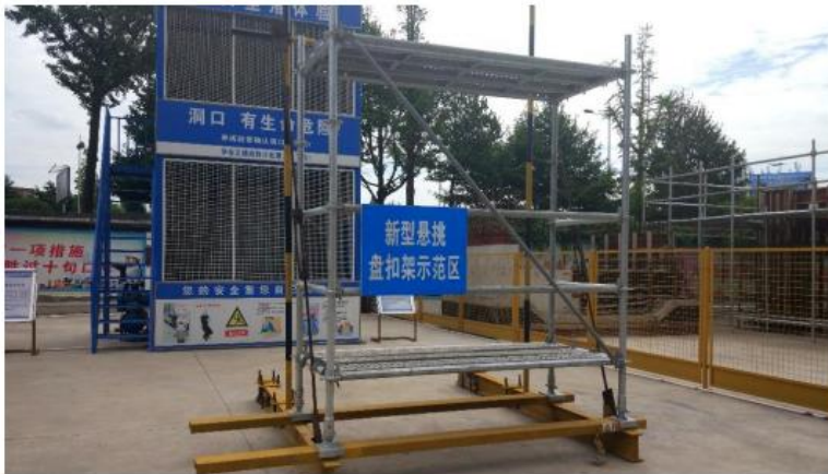
图 7-17 悬挑盘扣脚手架参照图
