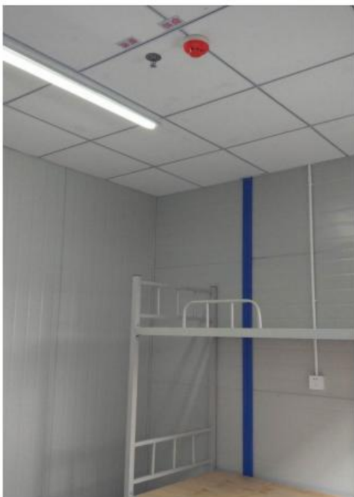
图 3-19 宿舍布置参照图（喷淋、烟感等）
