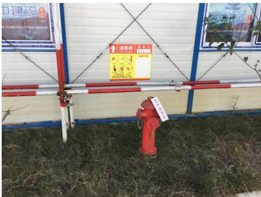
图 4-6 室外消火栓系统参照图
