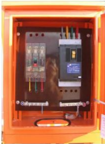
图 8-5 开关箱标准配置参照图 图 8-6 电焊专用箱标准配置参照图
