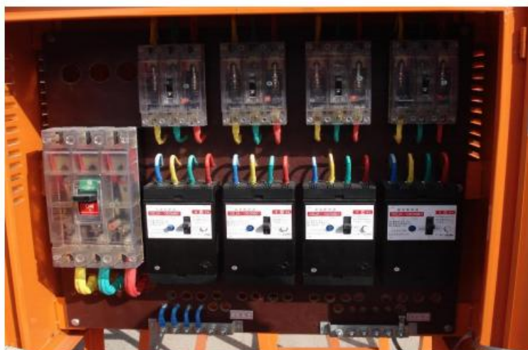
图 8-4 二级箱标准配置参照图
