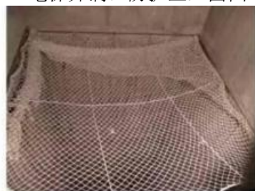
电梯井洞口安全平网水平防护实物图
