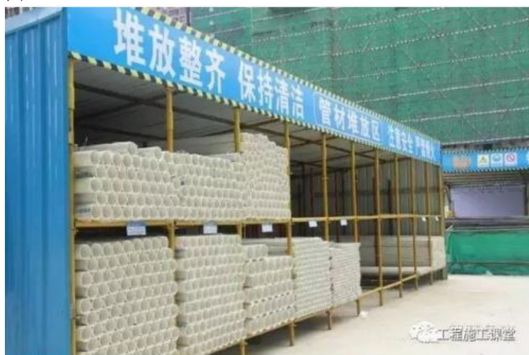
图 11-1 管材堆放参照图
