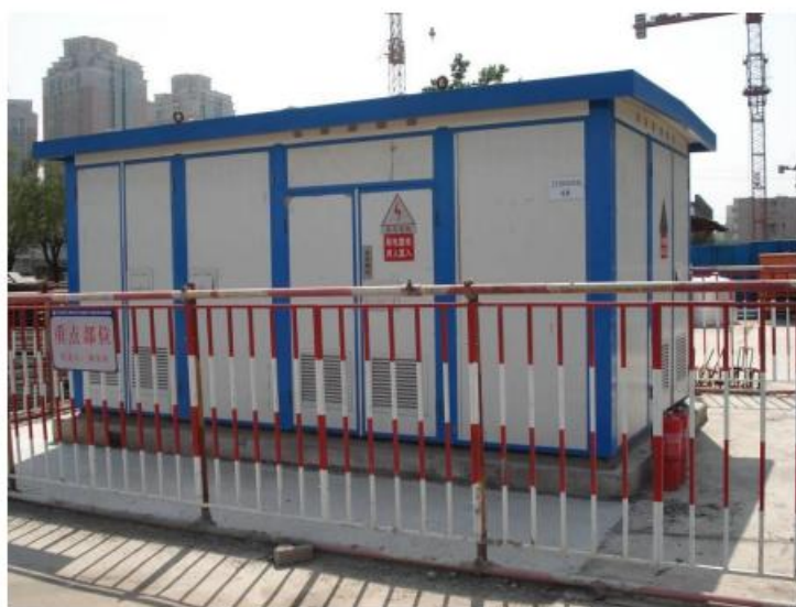
图 8-1 箱变标准防护参照图
