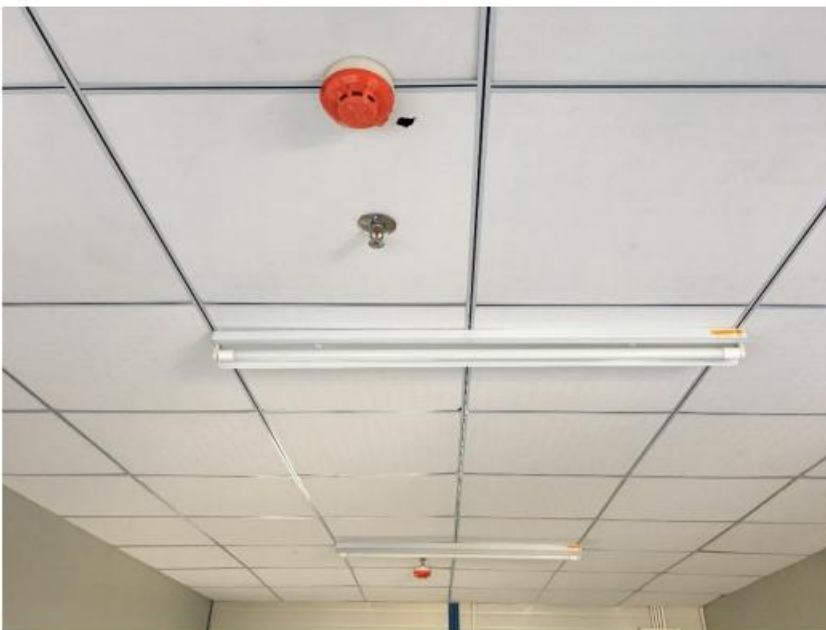
图 4-5 室内设喷淋、烟感参照图
