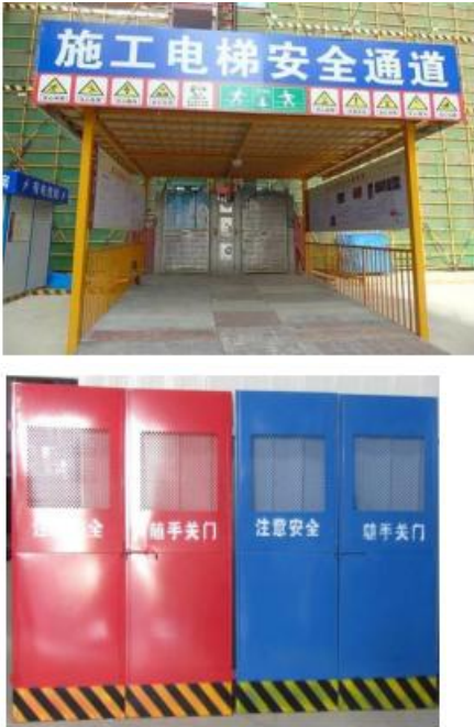
图 7-12 施工电梯入口安全通道参照图图 7-13 卸料平台安全防护门参照图
