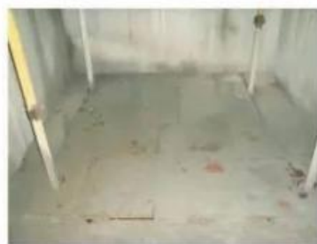
电梯井洞口模板水平防护实物图
