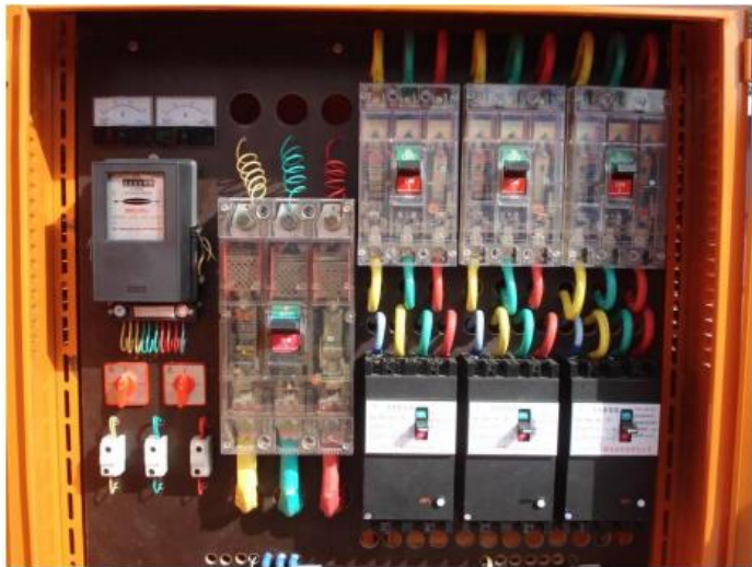
图 8-2 一级箱标准配置参照图
