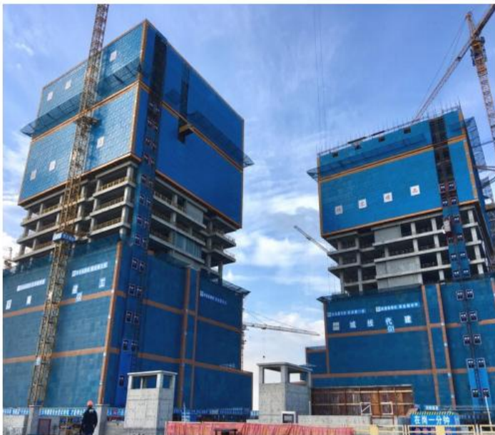
图 7-18 外脚手架安全网片参照图
