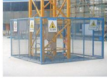
● 塔吊基础面防护实景图
