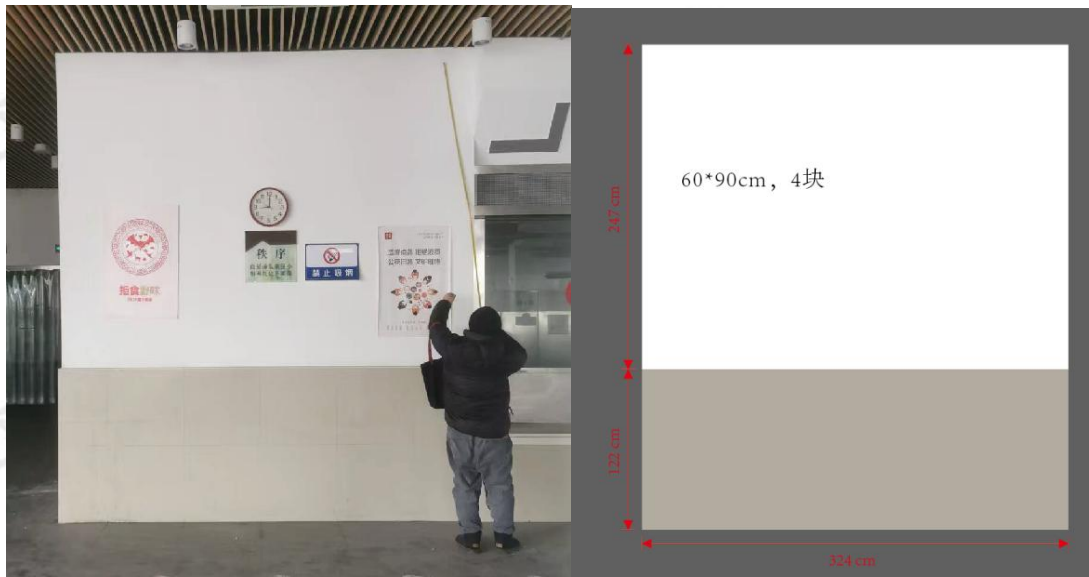
16、需要拆除的墙面照片和尺寸
