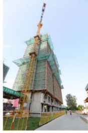
● 塔吊附着平台防护实景图
