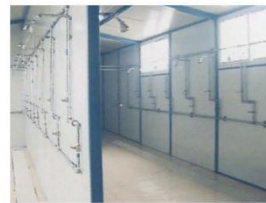
● 淋浴室实景图
