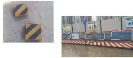
● 洞口防护实景图
