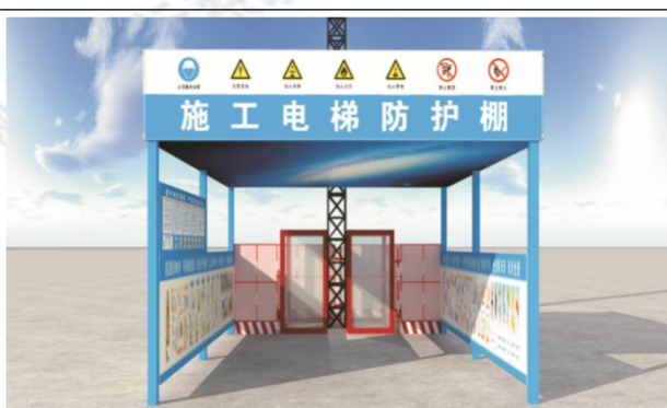
图 37 施工电梯防护棚
