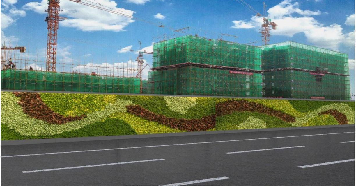
图 13 人工草皮砌筑式围挡
