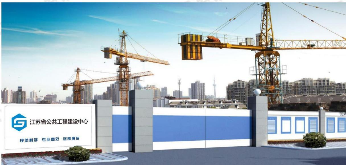
图 24 施工现场大门（无梁式）
