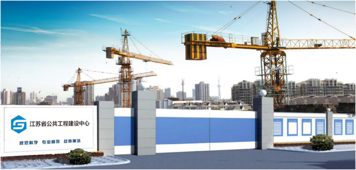
图 24 施工现场大门（无梁式）
