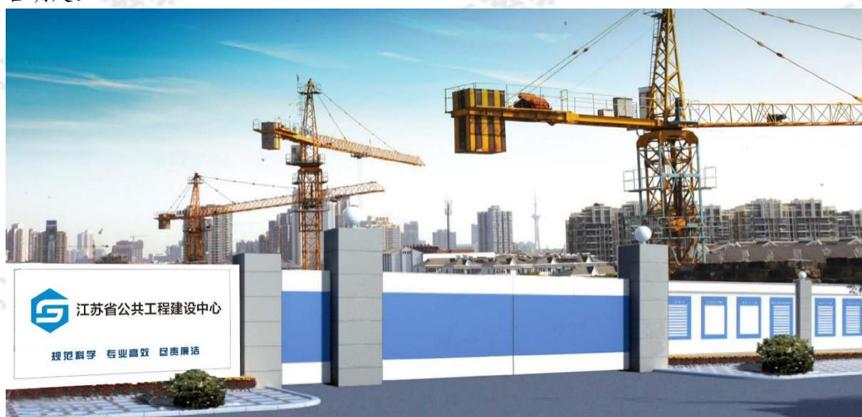
图 24 施工现场大门（无梁式）
