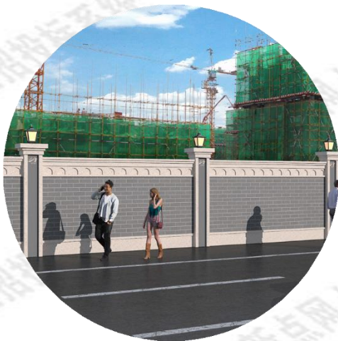
图 2 砌筑式围挡
