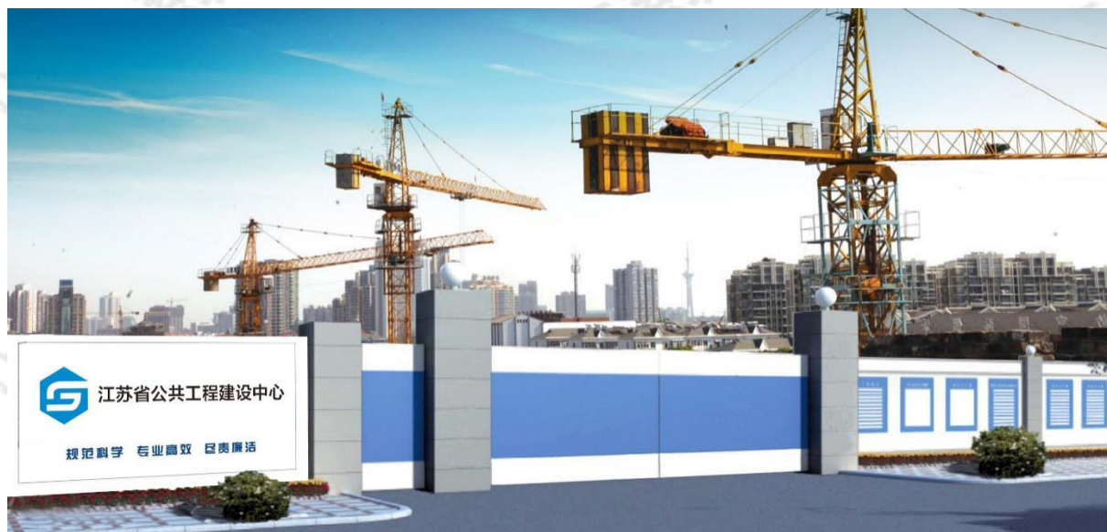
图 24 施工现场大门（无梁式）
