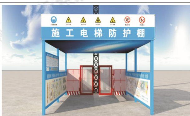
图 37 施工电梯防护棚
