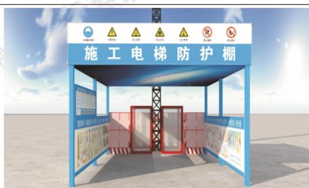
图 37 施工电梯防护棚
