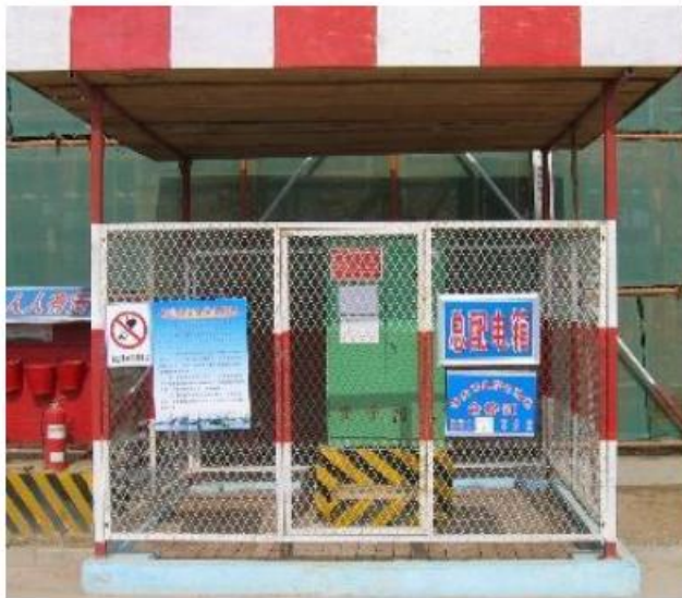
图 8-3 配电箱标准防护参照图
