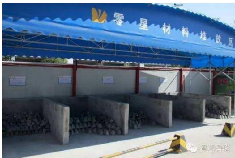
图 11-2 零星材料堆放参照图
