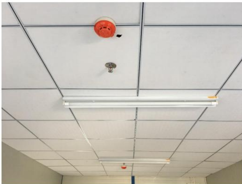
图 4-5 室内设喷淋、烟感参照图
