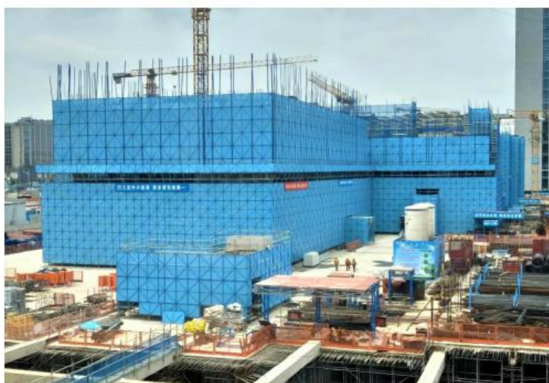
图 7-19 外脚手架安全网片参照图
