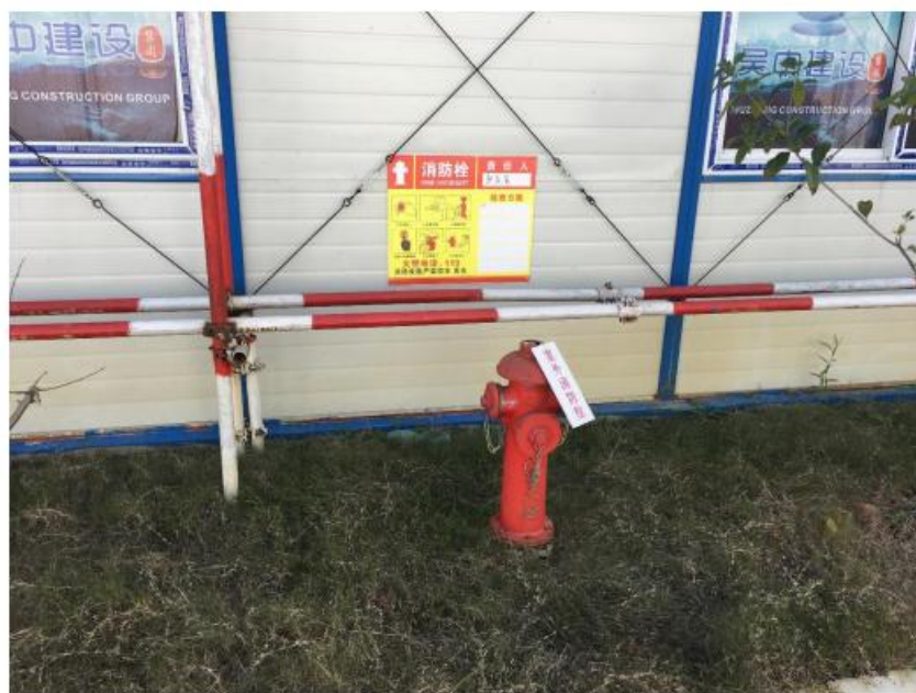
图 4-6 室外消火栓系统参照图
