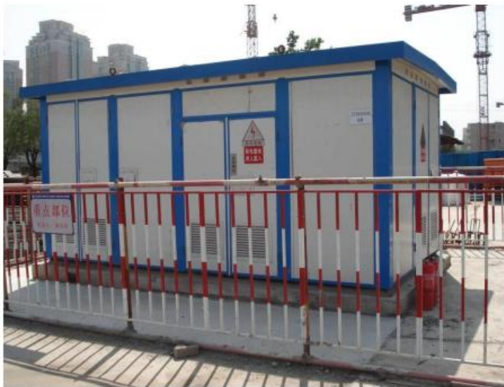
图 8-1 箱变标准防护参照图
