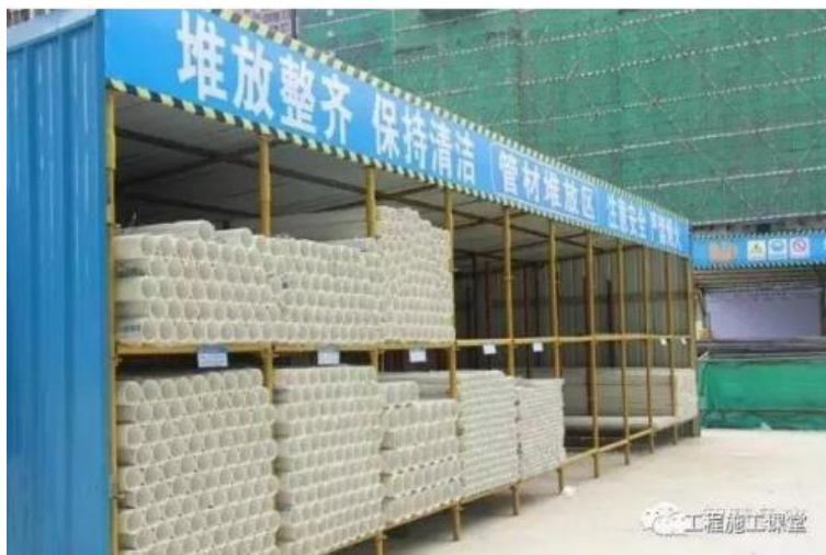
图 11-1 管材堆放参照图
