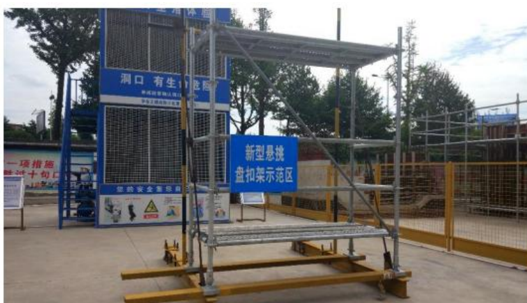
图 7-17 悬挑盘扣脚手架参照图
