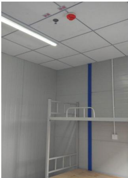
图 3-19 宿舍布置参照图（喷淋、烟感等）
