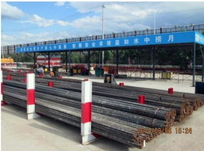
图 10-1 钢筋棚及钢筋堆放参照图
