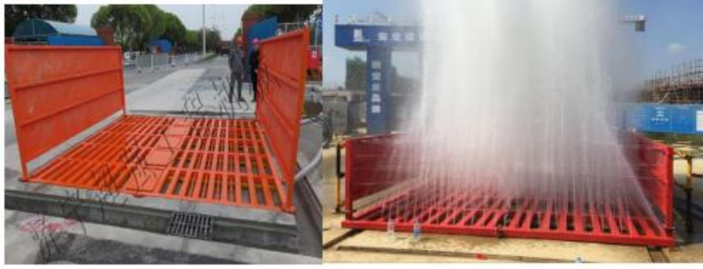
图 5-1 设置冲洗台参照图
