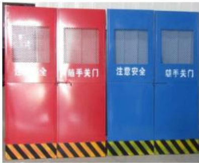
图 7-12 施工电梯入口安全通道参照图 7-13 卸料平台安全防护门参照图
