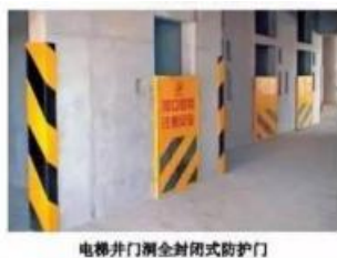
电梯井门洞全封闭式防护门
