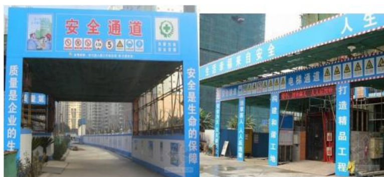
图 6-1 安全通道参照图
