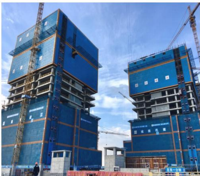
图 7-18 外脚手架安全网片参照图
