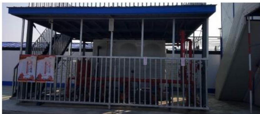
图 4-3 消防水箱和消防泵组参照图
