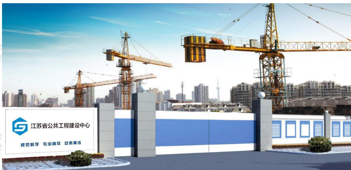
图 24 施工现场大门（无梁式）
