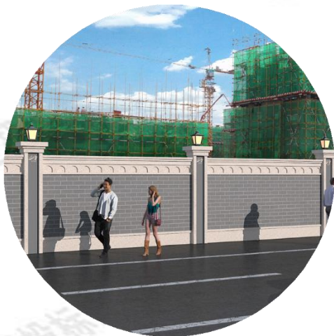
图2 砌筑式围挡
