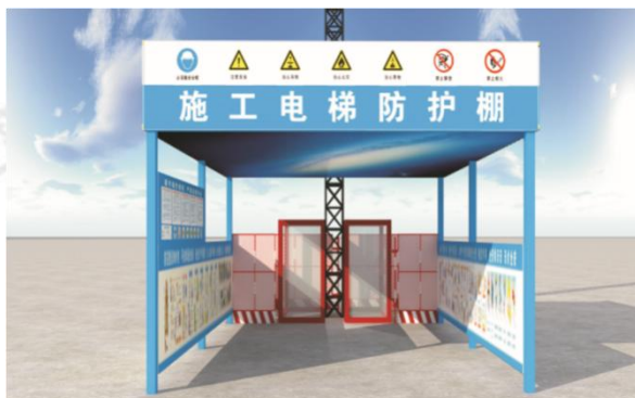
图 37 施工电梯防护棚
