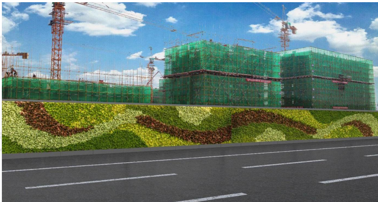
图 13 人工草皮砌筑式围挡
