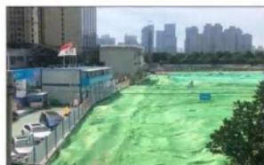
6针防尘网裸土覆盖
