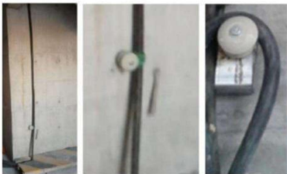
竖向电缆敷设及固定
