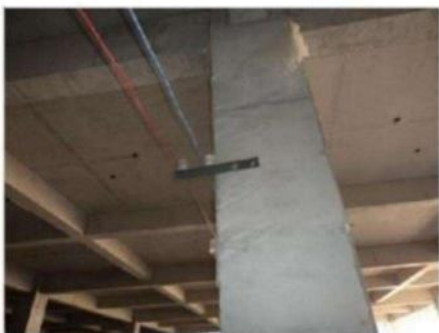
横向电缆敷设及固定
